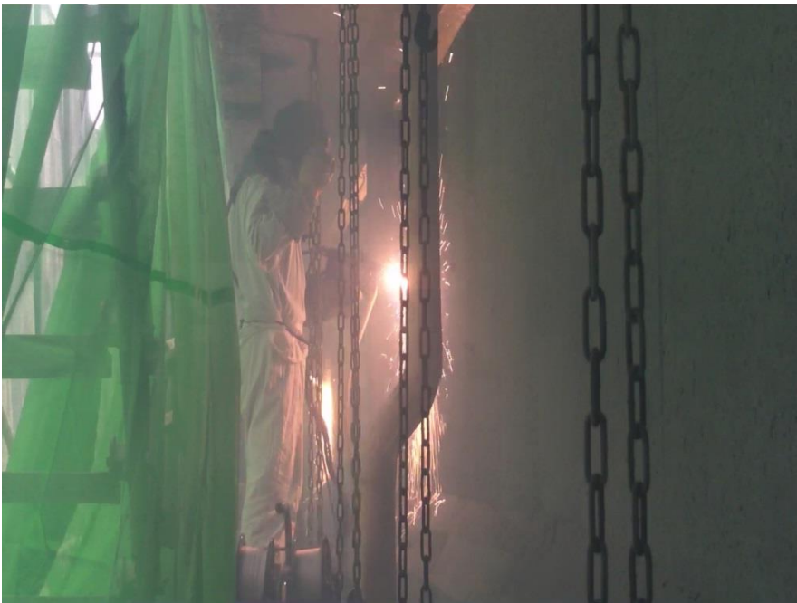
(コンクリート橋 (PC 橋) チタン溶射)
