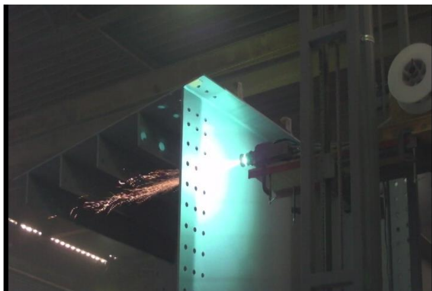
橋梁桁溶射
