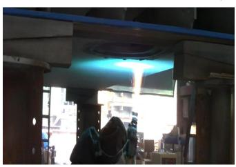
ガルバリウム組成溶射(Al-Zn 擬合金)の複合皮膜は、-900mmV~-1200mmVの電位で推移する安定した陰極性能を発揮するもので、鉄鋼表面を長期的に防食電位に保持することから、同等厚みの亜鉛メッキと比較して、7倍の以上の耐食性が確認されています。
